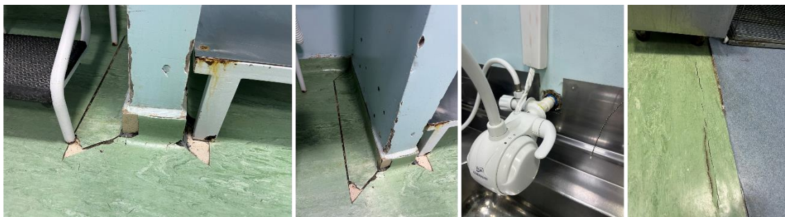
Figura 06. Área Suja (lavagem e descontaminação).
